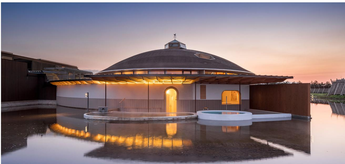
大浴場の屋根は、ポンピドーセンター・メスの屋根と同じ、各ジョイントに2方向の材しか交わらないよう六角形と三角形のジオメトリーを、上 下弦が木片で構成されたフィーレンディールトラス状の竹を編んだ帽子のような構造のドームとした。女性サウナには細い丸太を天井まで並べた木製ベンチを設けた。正面の大きな窓からは一面に広がるスイデンを望むことができる。壁には山形県産の果樹で制作した「果樹パネル」が掛けられ、自動給水によって木にかかる水分が蒸発し、果樹の香りが室内に広がると共に室内の湿度を一定に保つ役割を担っている。水風呂は既存露天風呂に隣接して配置し、スイデンに浸かっているような開放感を与える。男性サウナは既存男湯露天風呂の六角形の天窗に合わせて水風呂を六角形とし、サウナ室内のベンチも正六角形柱を組合せたハニカム構造で構成している。庄内の山並みを眺望できるように横長の窓を配置し、一番低いベンチは可動式のスツールとすることで自由に座る場所を移動させ、利用者が各々の風景を楽しめるようにした。天井は、既存屋根の木梁架構の形状を活かし、木梁の形成する六角形の彫込み天井とした。
